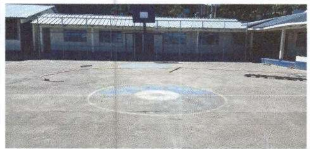
Foto 4: finalizando la instalación de malla galvanizada del establecimiento
