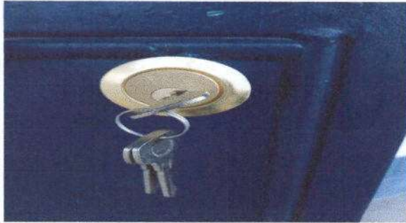
Foto1: Finalización de instalación de chapas de puertas de aulas de la Escuela.
