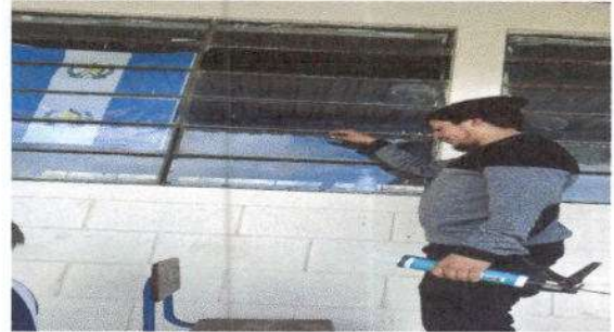
Foto 2: Finalización de instalación de vidrios de ventanales de aulas del establecimiento.
