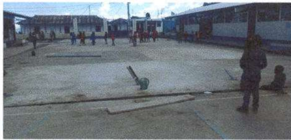
Foto No. 3: finalizando con la fundición de patio con torta de concreto del establecimiento
